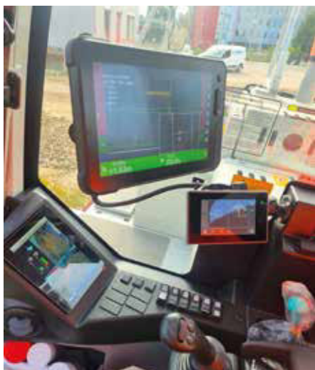
Durch den Bildschirm in der Kabine (Teil der Topcon-Maschinensteuerung) wird die Arbeit für Baggerfahrer wesentlich erleichtert.
